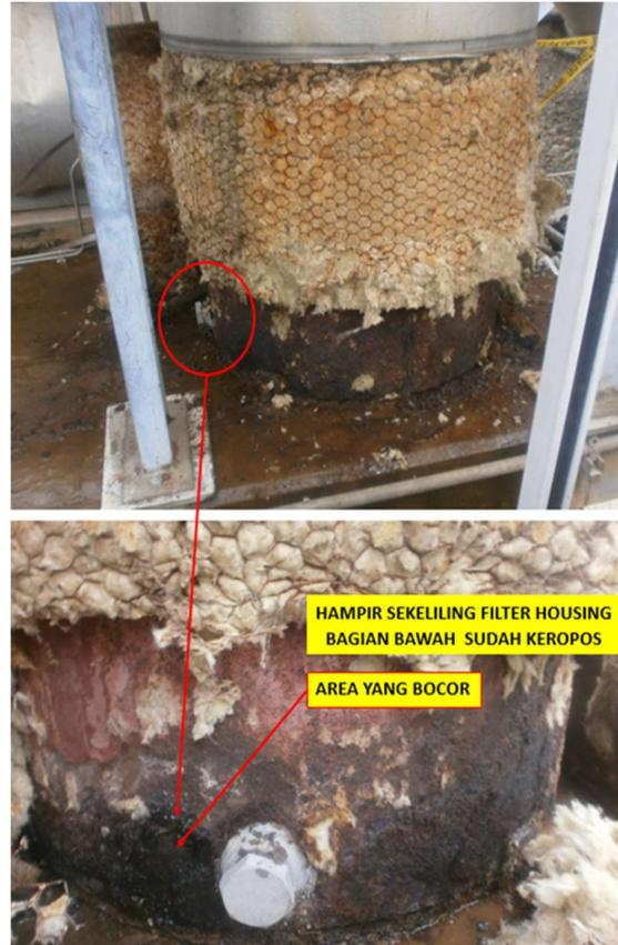
Gambar 1. Kebocoran pada duplex filter tank.
