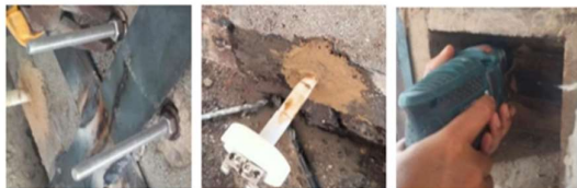
Gambar 6. Proses pengeboran dan pemasangan thermocouple .
