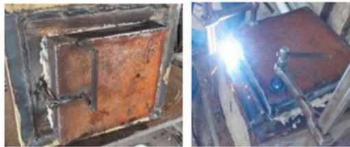
Gambar 8. Pemasangan dan pengelasan pintu.
