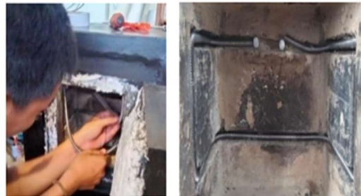
Gambar 9. Pemasangan kawat pemanas sesuai alur.
